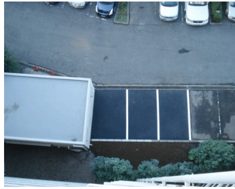
受水槽が無くなり駐車スペースが3台増加
